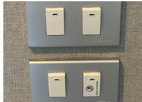
ภาพที่ 2.2-66 การแยกสวิทช์ควบคุมอุปกรณ์ไฟฟ้า แสงสว่าง
